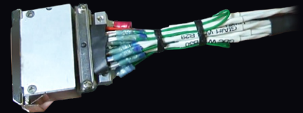
熱収縮スリーブ施工一例
